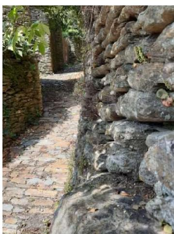
Calade récente au village de La Roque faite avec des pierres assez épaisses posées verticalement
